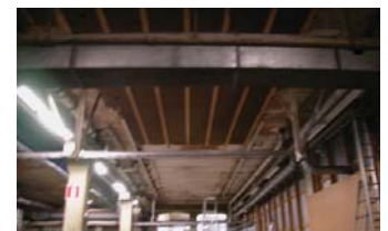
Keskiosassa on erilaisia rakenteita eri ajoilta. Vanha kappaholvi uudet betonirakenteet.
