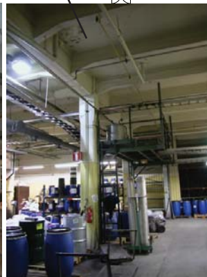
Uudet rakenteet: Hennebique järjestelmä
